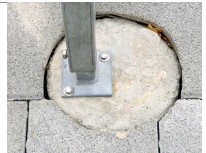
Verankerung auf Betonrohre.
