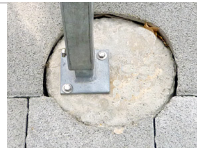
Verankerung auf Betonrohre.
