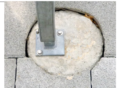
Verankerung auf Betonrohre.
