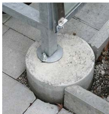
Verankerung mittels Schlaganker, nur in kompaktem Beton.
