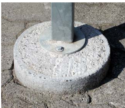
Verankerung mittels Plastikdübel und Schlüsselschrauben.
